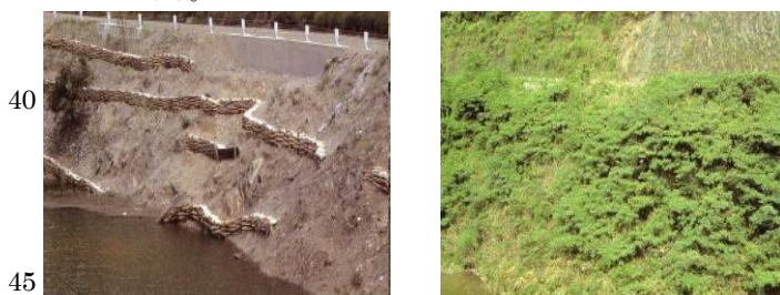
写真-5 シガラを組み種子を撒き出す (5) 写真-6 回復した植生 (5)
